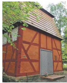
Rot leuchtet die frisch sanierte Kapelle. Fotos: Wolfgang Schmidt
