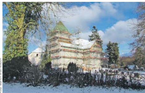
Winterpause bei den Bauarbeiten an der Kirche in Ahrensberg.
