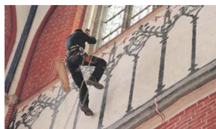
Die Kletterer befestigen ihre Seile im Dachstuhl. Foto: Martin Heider
