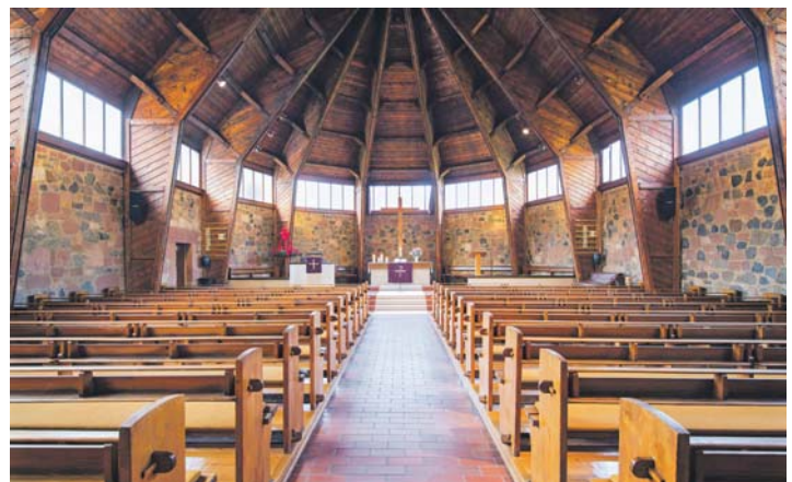
Wie ein Zelt oder wie ein umgedrehtes Boot wirken die Notkirchen, die Otto Bartning nach dem Zweiten Weltkrieg als Baukastensystem entwarf, hier die Pankratius-Kirche in Gießen. Foto: epd-bild/Rolf K. Wegst
