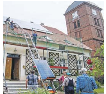
Abbau der Solaranlage vom Pfarrhaus der Gemeinde Atterwasch. Foto: picture-Allianz/dpa
