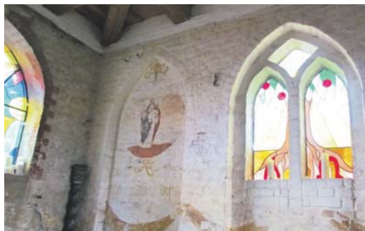
Studenten aus Hildesheim sicherten die Wandmalereien. Die Fenster wurden von Glaser-Berufsschülern aus Travemünde angefertigt und eingesetzt.
