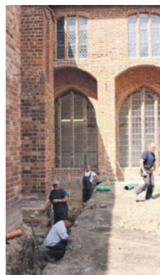
Noch ist kein Bauende in Sicht: am Johanniskloster Stralsund.
