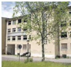
So sah das Gebäude vor der Sanierung aus.
