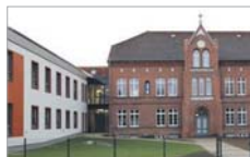
Links der neue Anbau.
