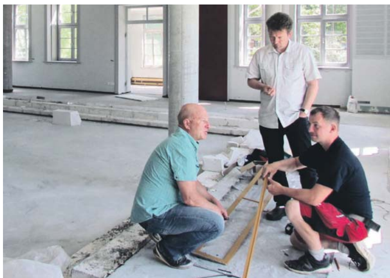
Hoffnung auf baldigen Abschluss der Bauarbeiten im leerräumten Gemeindsaal des Doberaner Amtshauses: Pastor Albrecht Jax, Mitte, im Gespräch mit den Handwerkern Roberto Schruppner und Dirk Schreiber. Foto: Marion Wulf-Nixdorf
