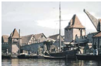
Im Hamburger Hafen der Hansezeit befördern riesige Holzkräne die besonders schwere Fracht von Schuten und Ewern an Land – und umgekehrt.
