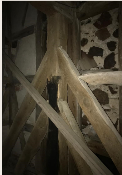
fehlerhafte Glockenaufhängung
