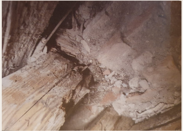
zersetzte Dachbalken
