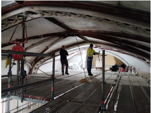
Begutachtung der Fortschritte am Deckengewölbe Foto: Cornelius Wergin
