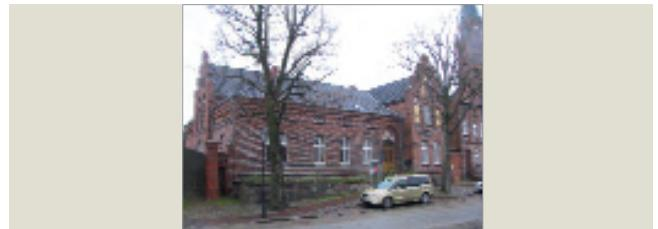
Im Pfarrhaus Röbel, St. Marien wurden 2009 die Dachkonstruktion, das Traufmauerwerk, die Schornsteinköpfe sowie die gesamte Dachdeckung instand gesetzt.
