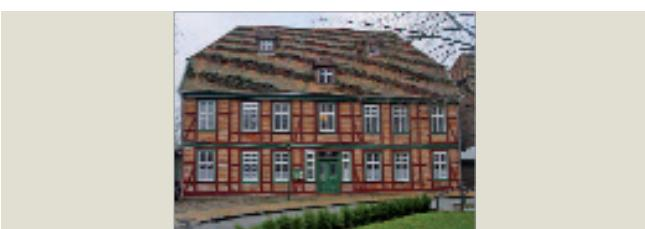
Im Pfarrhaus Crivitz erfolgten nach einer abgestimmten Gesamtplanung 2004 die Erweiterung des Gemeinderaumes und die Sanierung der Fassade im Schweltenbereich, 2005 und 2006 die Sanierung von Dachstuhl, Dacheindeckung und Fachwerkfassaden und 2008 der Um- und Ausbau der Pfarrwohnung im Obergeschoß.
