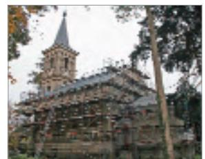
*2009 wurden das Traufgesims saniert und das Dach wieder mit Schiefer eingedeckt.*
