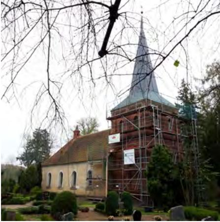
Seit einigen Wochen ist der Kirchturm der Kladower Kirche eingerüstet und es wird gebaut. Die Verfugung des Mauerwerkes des Turmes war defekt und sorgte für massive Feuchtigkeitsschäden. Dabei mussten auch einige kaputte Steine des Mauerwerkes ersetzt werden und der Übergang vom Turm zum Kirchenschiff wird auch wieder instandgesetzt. Die Sanierung der Kirchturm-Außenhaut ist ein erster Schritt, um ein weiteres Eindringen von Regenwasser in das Mauerwerk zu verhindern und damit dieses
