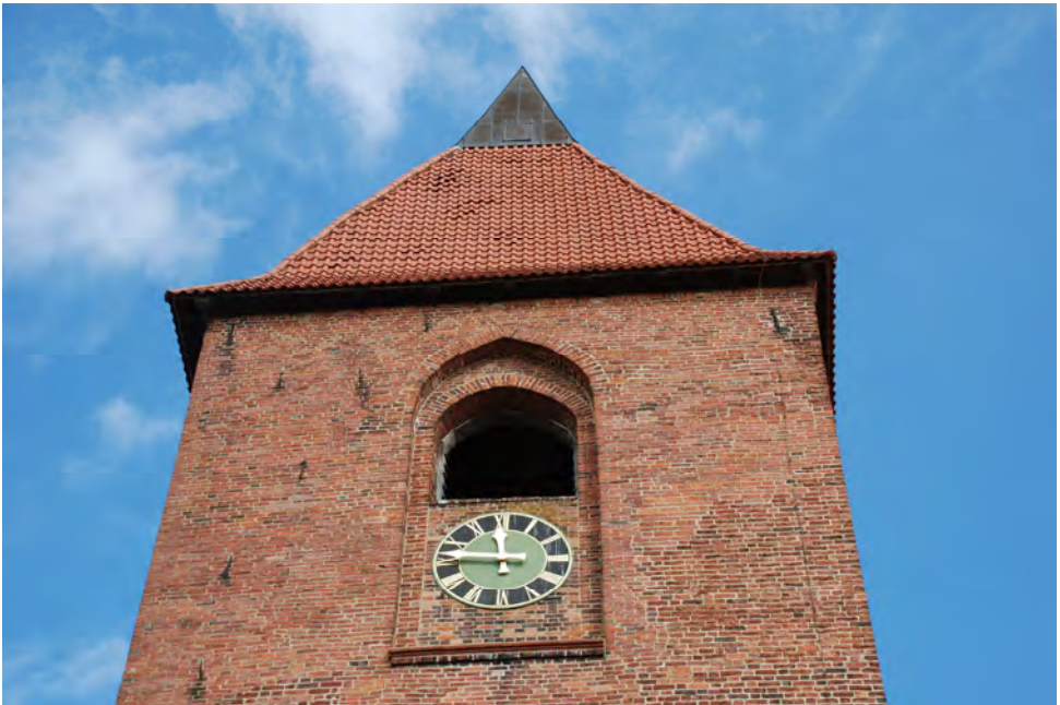
Das Schallloch auf der Südseite ist geöffnet zur Einholung der Glocken
