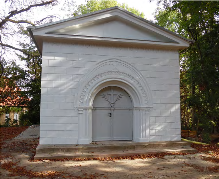
Nach der Sanierung im Oktober erstrahlt die Kapelle in Swantow wie neu. Im kommenden Sommer soll sie einen Namen erhalten. Fotos: Diana Weltzien
