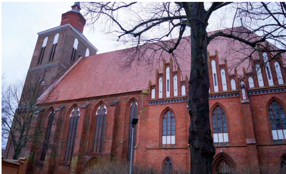
Mit der erfolgreichen Instandsetzung des Kirchturms ist die Grundsanierung der St. Petri Kirche nach rund 37 Jahren abgeschlossen. Foto: Sebastian Kühn
