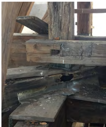
Vorher und nachher: Links ist der durchgefaulte Fußpunkt des Ständerwerks zu sehen, rechts die neu entstandene Zimmermannsarbeit. Fotos: Reinhard Röske
