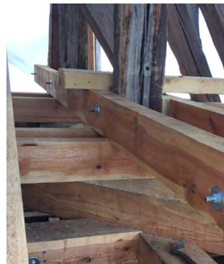
Vorher und nachher: Links ist der durchgefaulte Fußpunkt des Ständerwerks zu sehen, rechts die neu entstandene Zimmermannsarbeit. Fotos: Reinhard Röske
