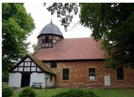
Die Trinitatiskirche in Ferdinandshof bekommt einen neuen Außenputz.
