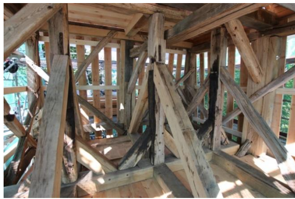
Abb. 21: Sanierte Glockenstube (vor Einbau der historischen Bronzeglocke)
