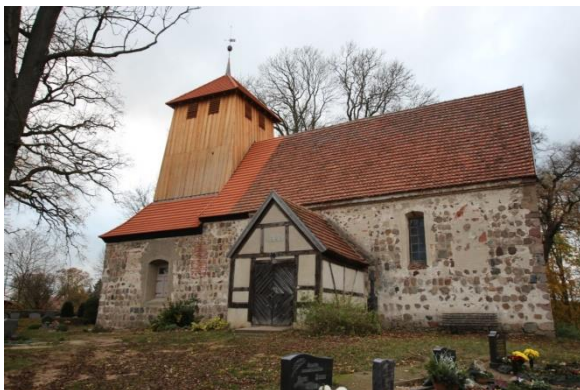
Abb. 20: Ansicht nach erfolgreicher Sanierung
