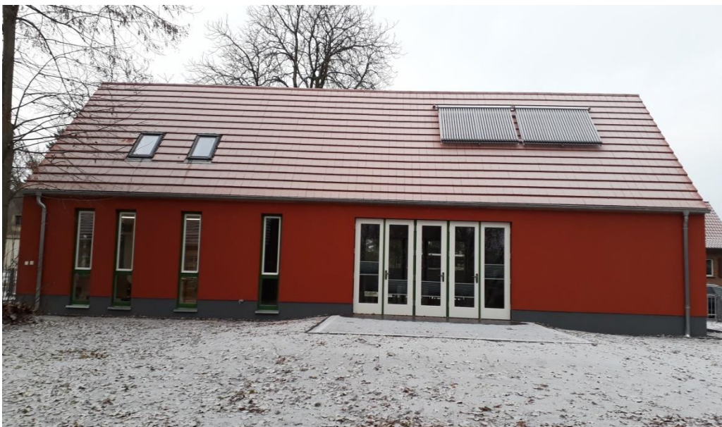
Abb. 13: Neubau des Gemeindezentrums mit Amtszimmer und Gemeinderäumen
