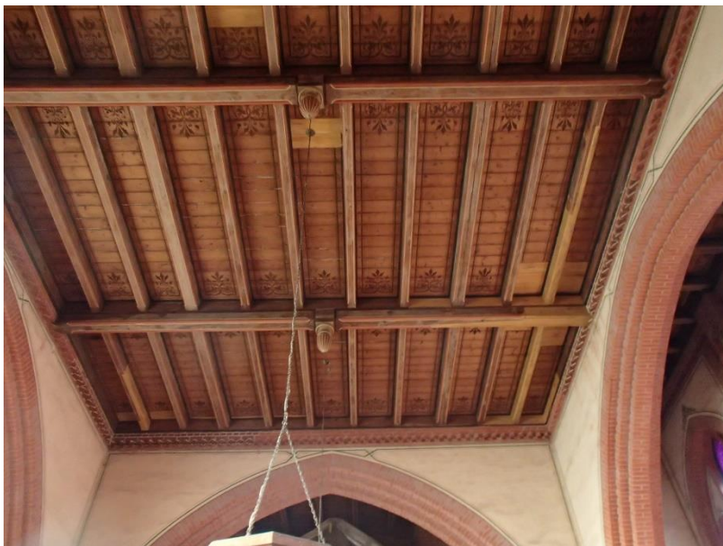
Abb. 11: Kirche Blücher – Innenraum mit sanierter Holzdecke
