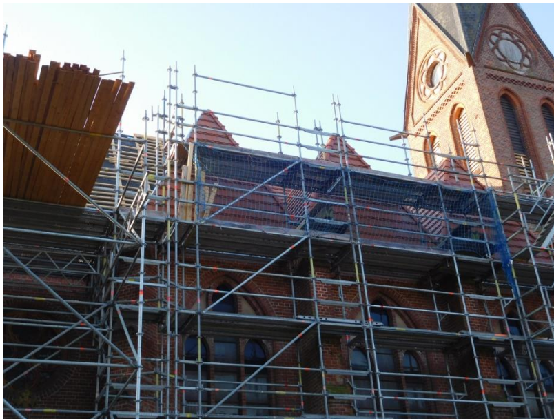
Abb. 10: Kirche Blücher – Zustand nach Fertigstellung Dachsanierung
