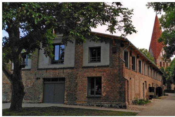
Abb. 7: Ansicht nach der Sanierung
