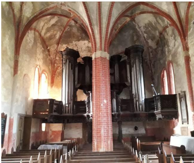
Abb. 4: Blick zur Orgelempore vor der Sanierung
