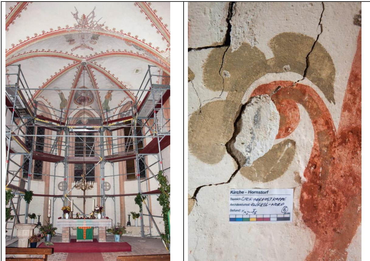
Abb: 14 und 15: vor der Sanierung
