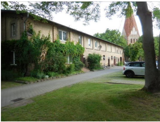
Abb. 6: Hofansicht vor der Sanierung
