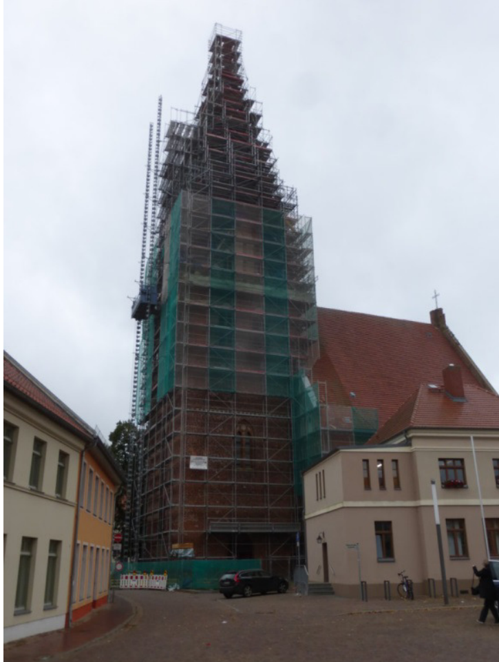
Kirche Röbel, Turmsanierung - Propstei Neustrelitz
