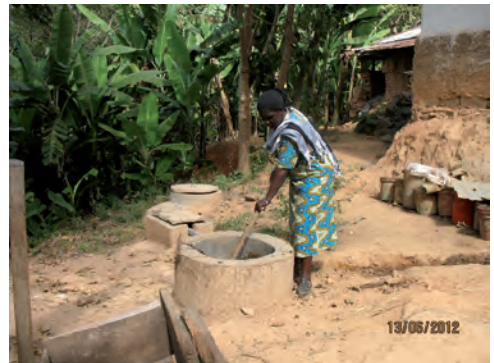
unterirdische Biogasanlage in Tansania
