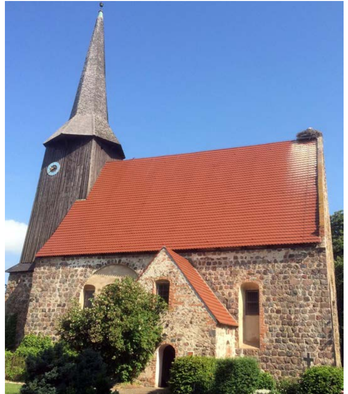
Eine Station: die Kirche Cölpin mit Storchennest
