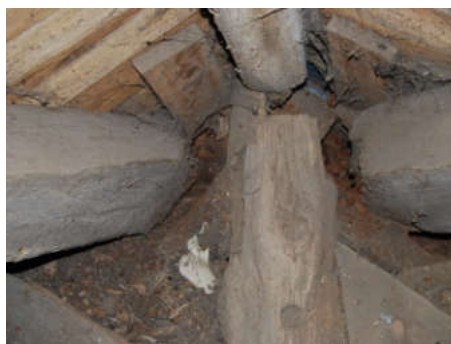
Zustand der Balken im Turm.
