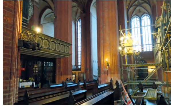
Neuer Gottesdienstort unter der Orgelempore Foto: Antje Exner
