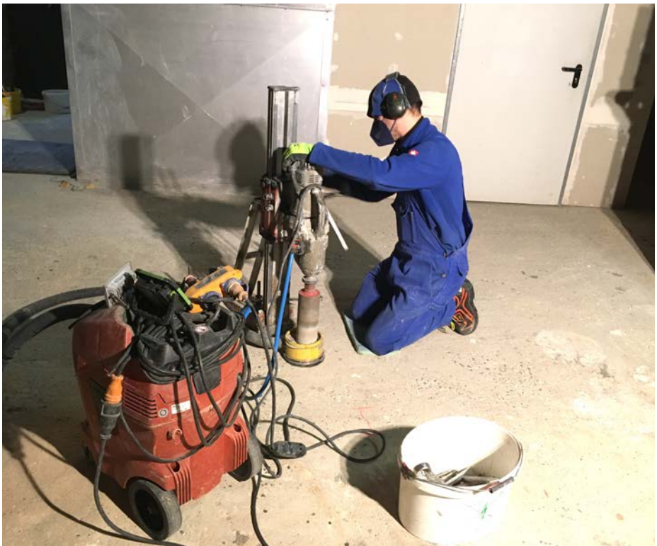
Kernbohrung zur Probeentnahme in einer Betonzwischendecke, Foto: Reinhard Wegener
