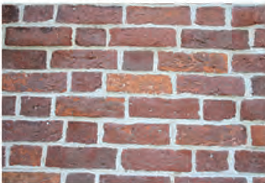
Im gotischen Verband gemauertes Mauerwerk auf der Nordseite der Kirche von Hohen Viecheln
