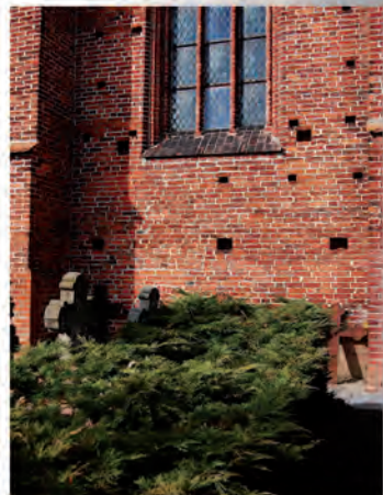
rechts Südwand mit deutlich vergrößerten Verzahnungs- löchern für den Dachstuhl der ehemaligen Sakristei
