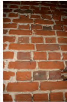
Mauerwerk im Bereich des Holzturms
