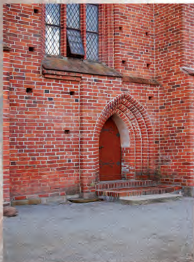
Portal auf der Nordseite der Kirche Gerüstbau
