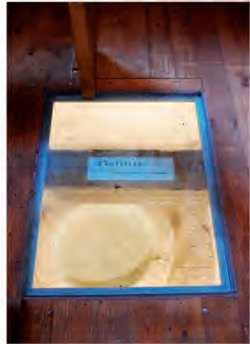
Blick durch das Panzerglas auf die Reste einer Taufünfte unter der linken Seitenempore
