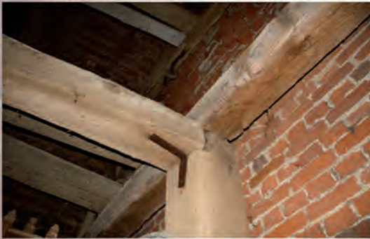
Mauerwerk im Bereich des Holzturms
