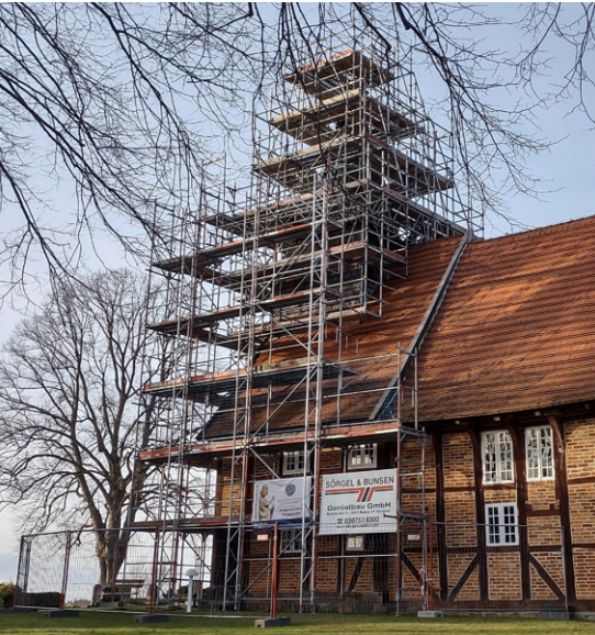
Einrüstung des Kirchturms
